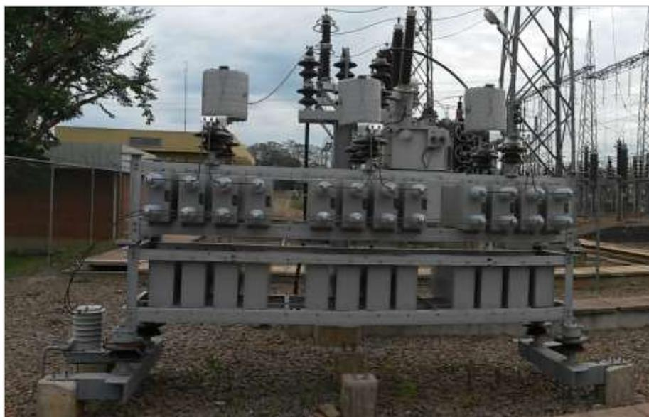
Figura 3.5: Banco de Capacitores de 12 MVAR tipo subestación. ES-COV.
