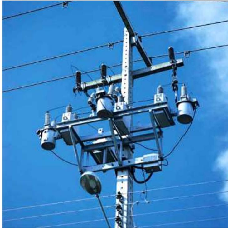
Figura 3.6: Banco de Capacitores 600 kVAr tipo poste.
