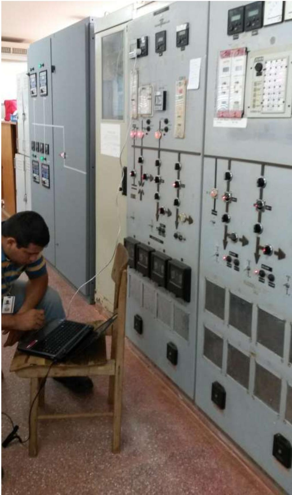
Figura C.5: Medición de corriente a través de VARcorder.
